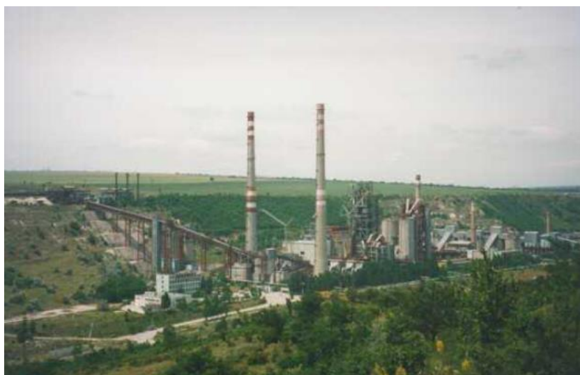
Fig. 1. Uzina de ciment Lafarge Ciment Moldova SA, Rezina
